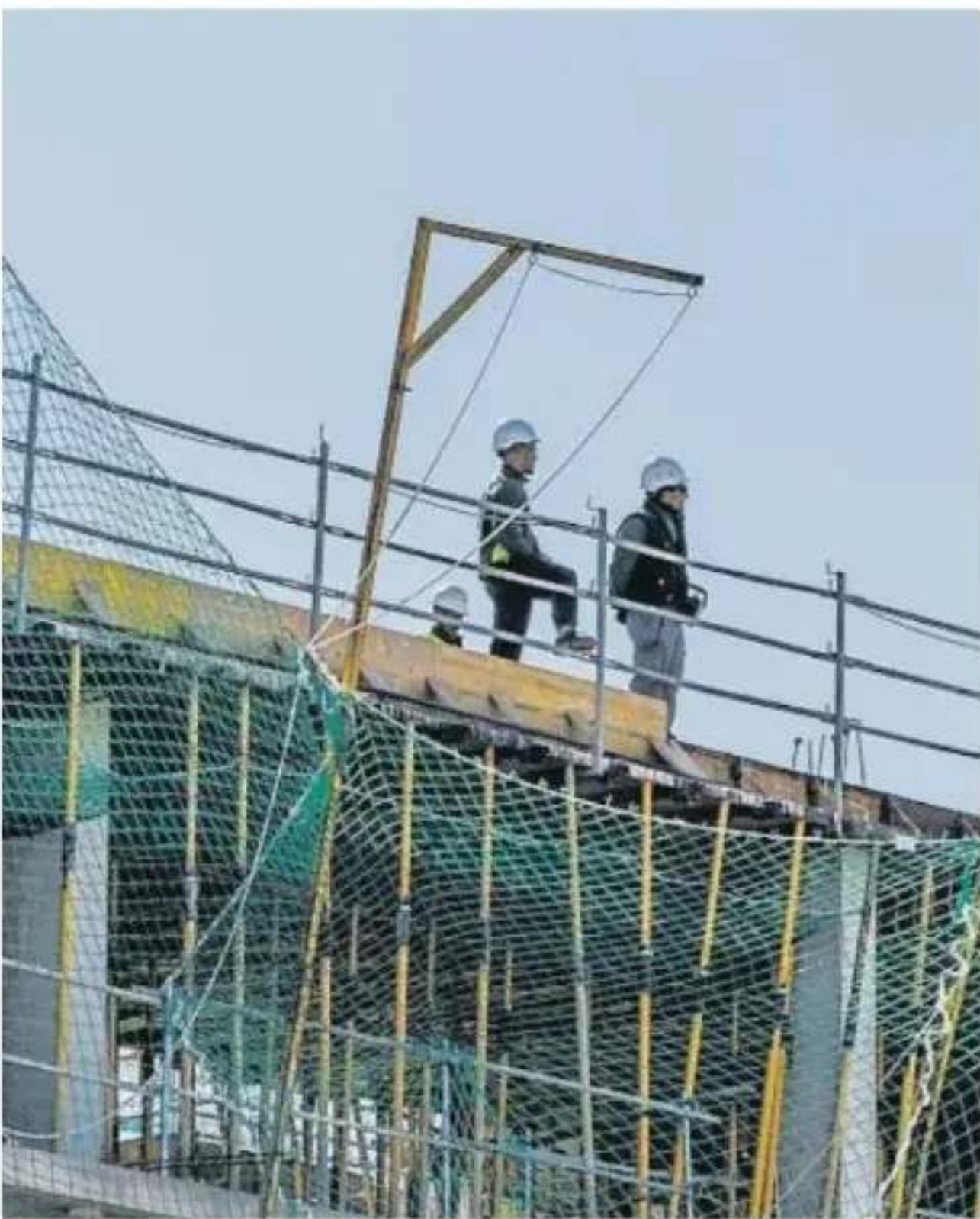
Trabajadores en una obra
